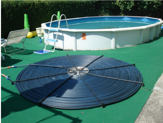
Položaj kolektora pored bazena
